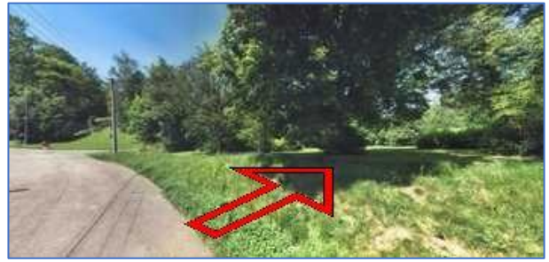
pohled na silnici v ulici ČSA k JZ
